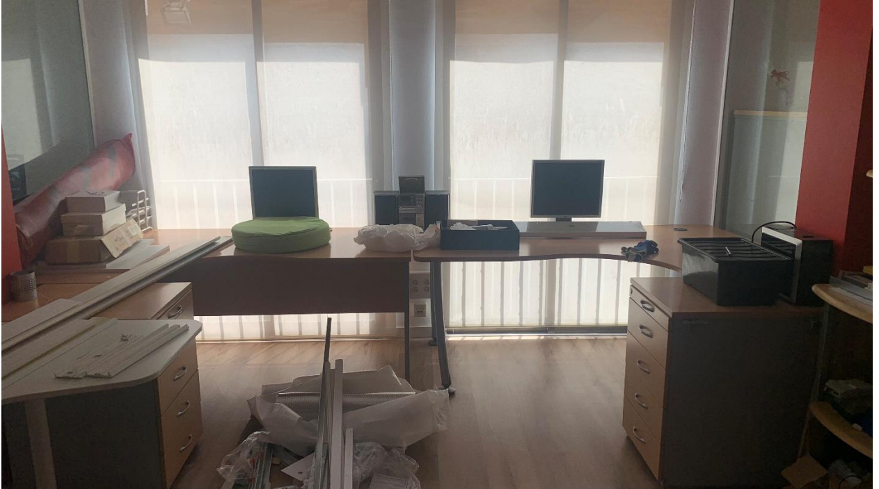
Ilustración 10. Oficinas de Comarcal TV (en reformas)
